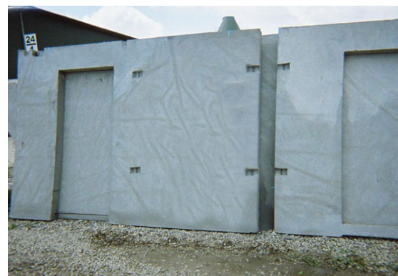
Modul de perete prefabricat
