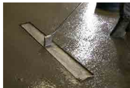
Pentru finisare utilizați o gletieră
