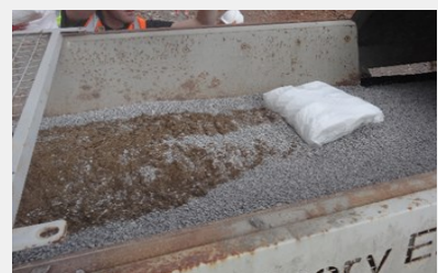
Adaugarea fibrelor cu nisipul si agregatele
