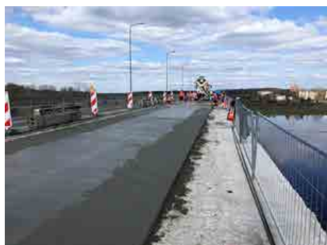
Placă suprabetonare pod, armată exclusiv cu fibre Durus
