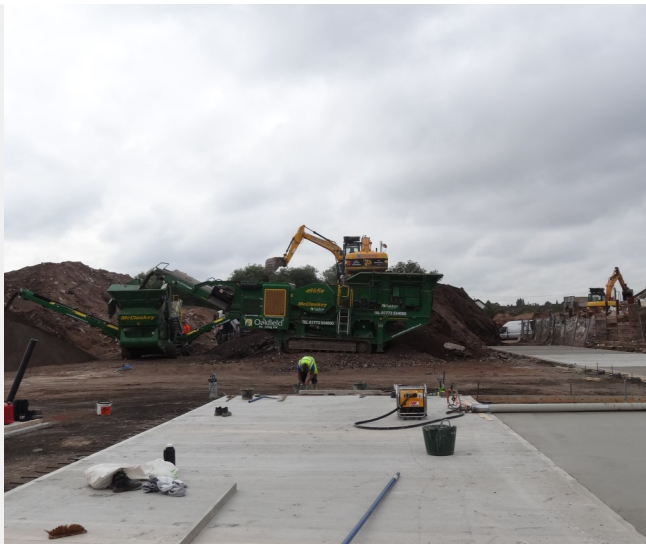
Lucrari continue pe durata turnarii platformei betonate
