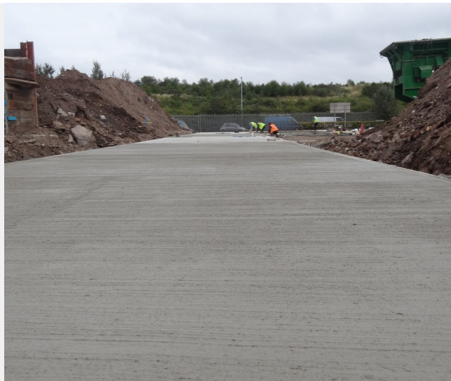
Finisare cu perie abraziva si rosturi de contractie taiate la fiecare 6 m
